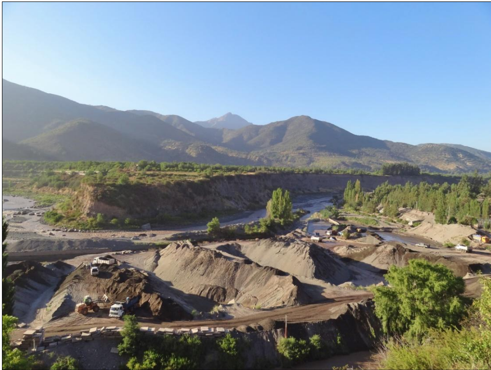
Figura 4.4. Terraza del río Maipo y zona de extracción de áridos, sector Las Vizcachas.
