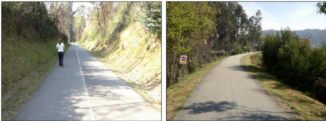
**Figura 38: Aspeto das margens da pista cicloturística: A) Taludes em terra; B) Margens sem proteção.**
