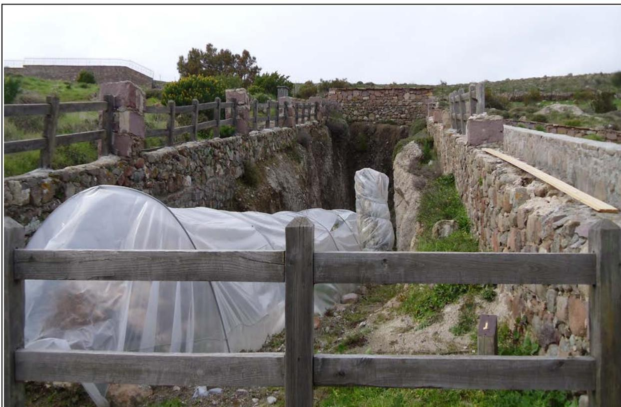
**Figura 6.1** – Pormenor dos trabalhos de conservação – cobertura plástica temporária e alargamento do muro de contenção (à direita) - implementados no geossítio n.º 1 – do trilho 1 (no P.F.P.) - observado a 4 de março 2011.
