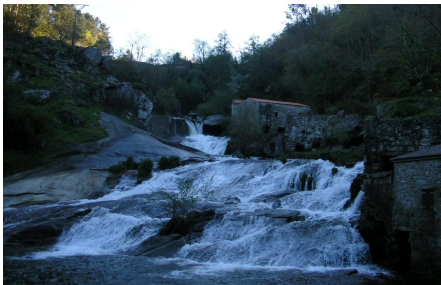
Fig. 101 - Descontinuidade topográfica na cascata de Barosa - rio Agra (perspetiva a juzante)
