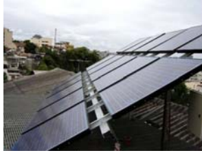
Figura 2. Painel Solar Fotovoltaico
