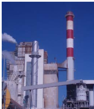
Figura 3. Efluentes gasosos - chaminé
