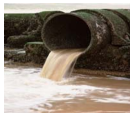
Cano de Esgoto
